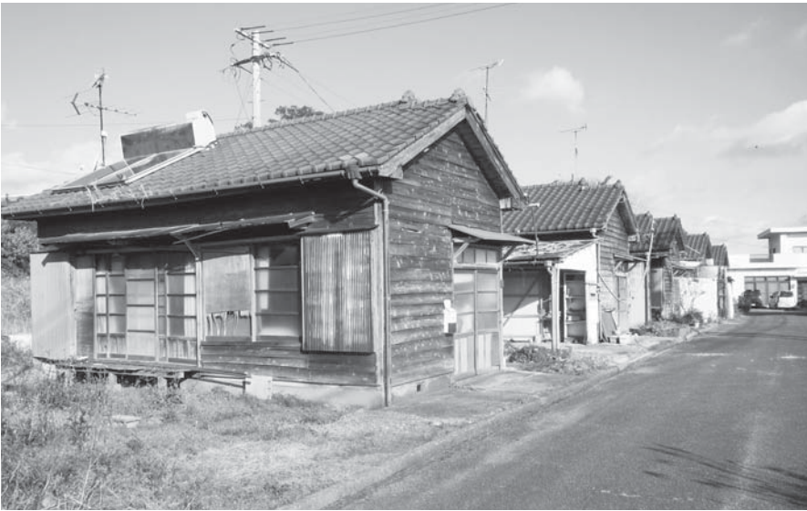
老朽化が激しい安国寺住宅
