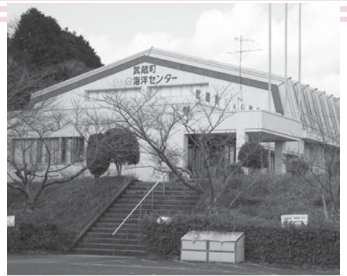
耐震補強工事予定の武蔵B&G
